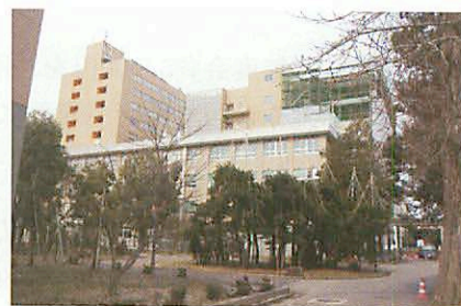
学部校舎北側に「コラボ弘大」建設中
