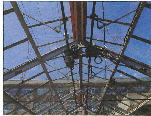
修理した天窓制御装置
