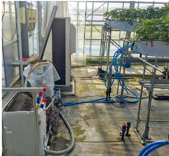
地中熱ヒートポンプによって夏のイチゴ培地をやっている様子です。
