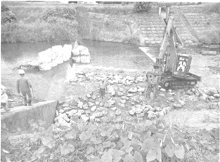
五戸川に設置した魚道。石を扇状に配置している＝7月、五戸町
