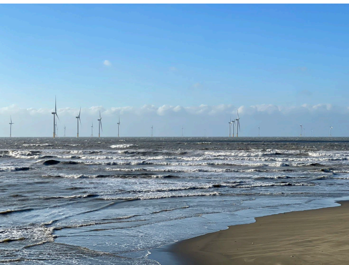
台湾は洋上風力発電の社会実装先進地である（苗栗龍鳳漁港沖）
